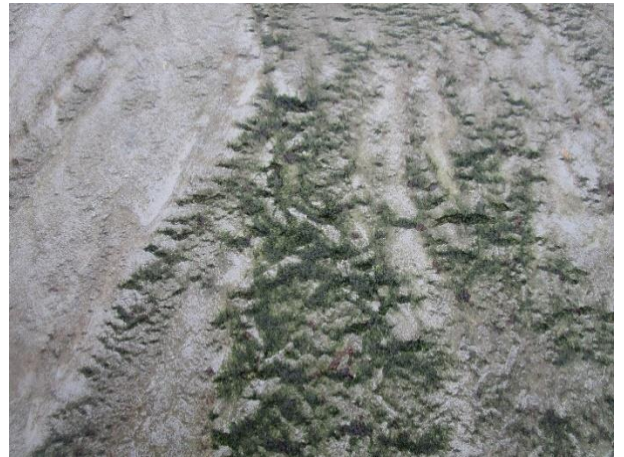
Photo n°26: Novaplak Bloc A le 13 décembre 2021
