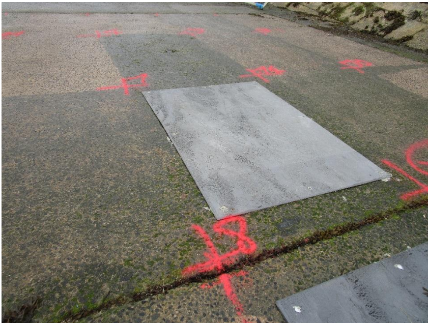
Photo n°22 : Novaplak le 10/09/2021 juste après la pose.
