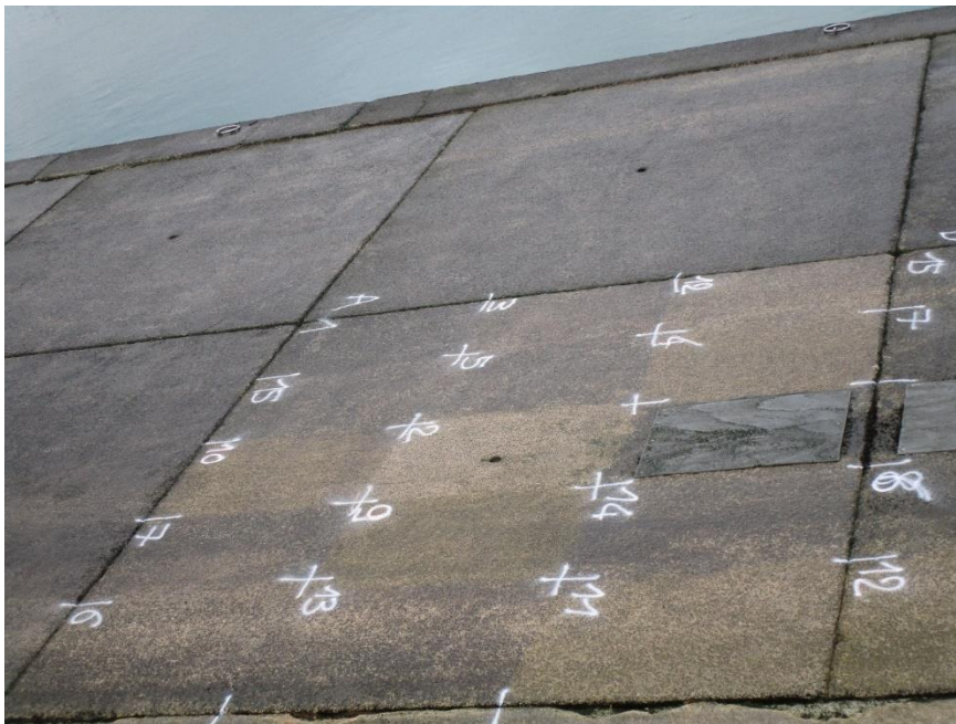
Photo n°43 : Bloc A le 13 décembre 2021 à la fin de l'essai
