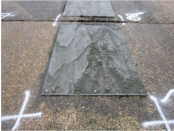
Photo n°25 Novaplak bloc A le 13 décembre 2021
